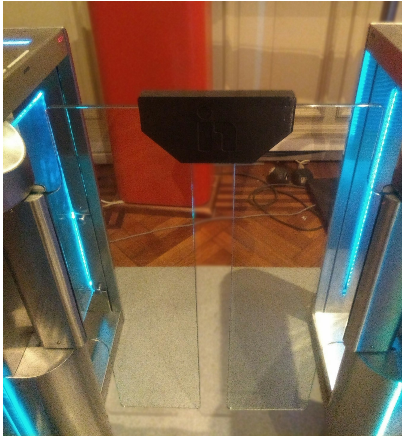
Figura 9. Alinear vidrios/acrílicos de Puertas de equipos laterales.
