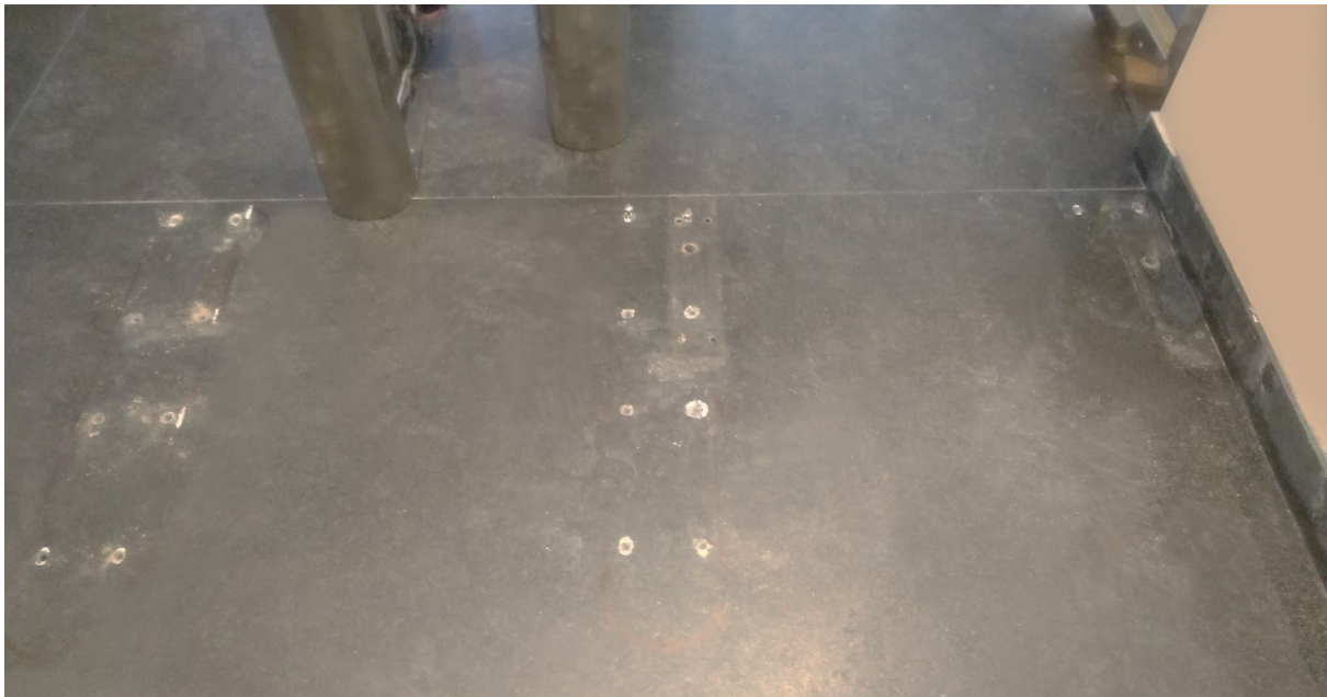
Figura 1. Perforaciones diámetro \varnothing 10\text{mm} para amurado de equipos.
