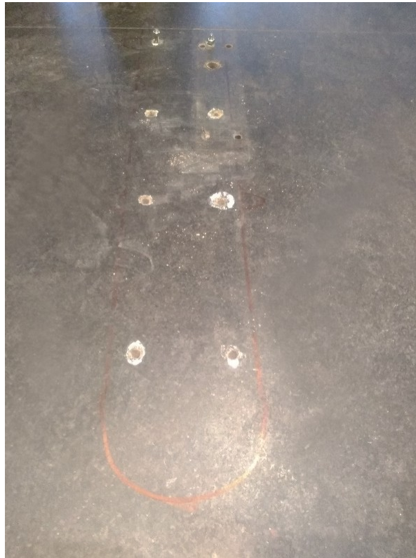
Figura 2. Detalle de huella y perforaciones diámetro \varnothing 10\text{mm} para amurado de equipos.
