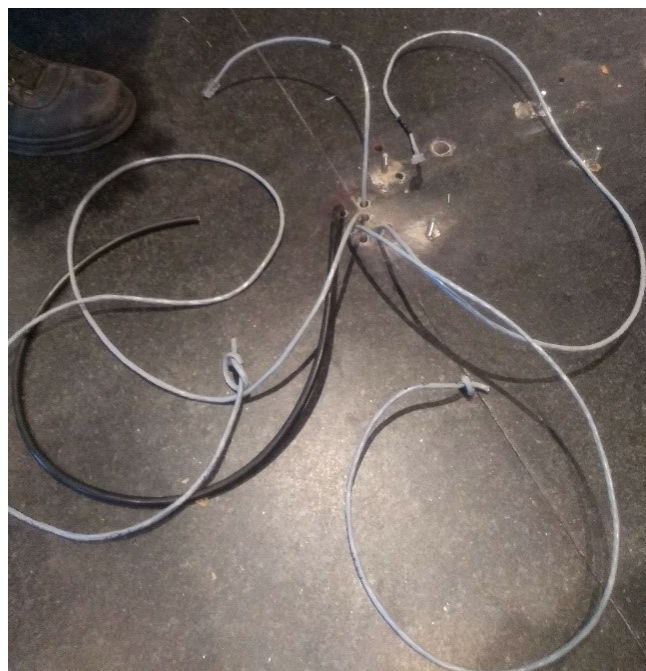
Figura 12. Cableado de la instalación, potencia, red e intercomunicación.
