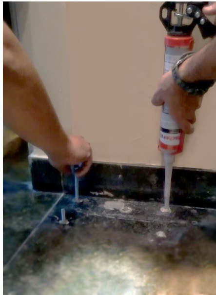
Figura 3. Inyectar mortero líquido de secado rápido (FISCHER FIS VS 300 T o similar) en los agujeros perforados e introducir espárragos de fijación.
