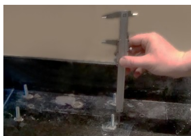
Figura 4. Verificar que la altura de los espárragos no supere los 40 mm.
